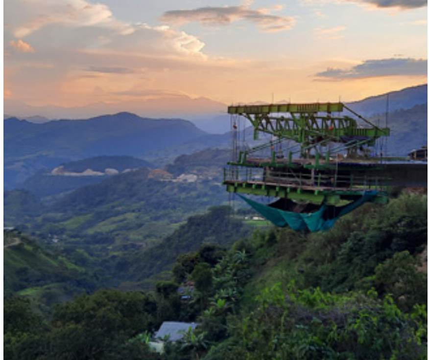
↑ Obras del Túnel Guillermo Gaviria Echeverri en Antioquia, Colombia
