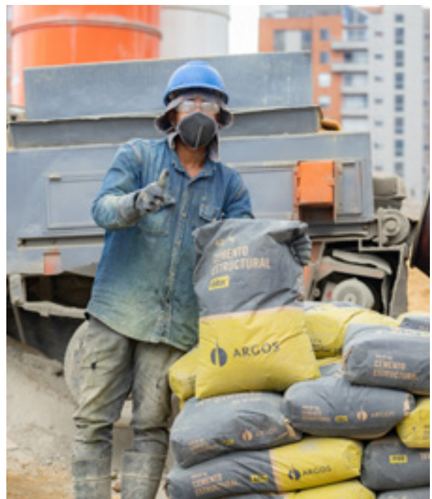
↑ Nuestro Cemento Estructural Max en obras de Bogotá, Colombia
