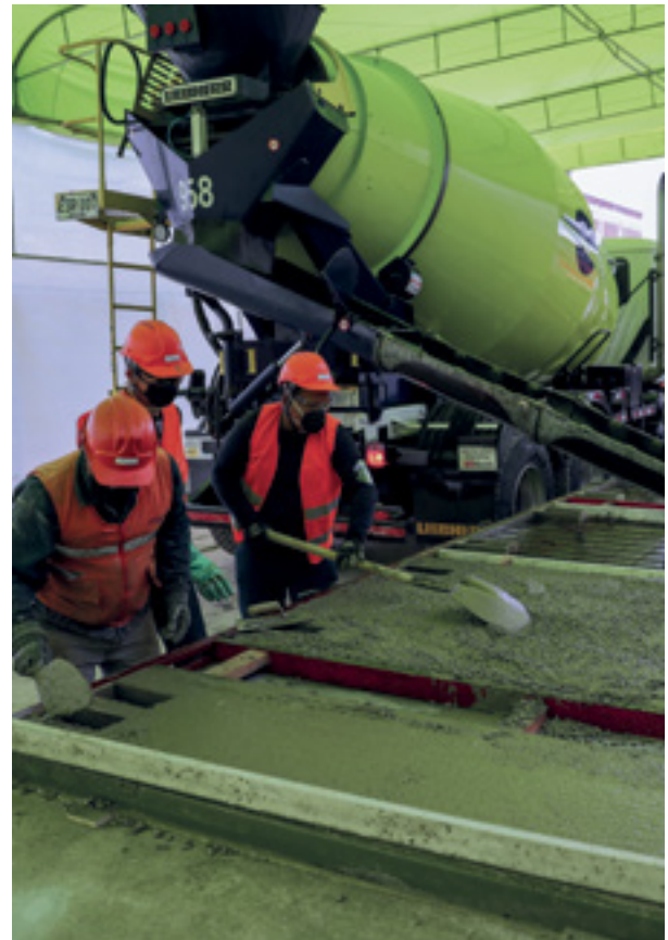
↑ Proceso de producción de módulos en concreto
