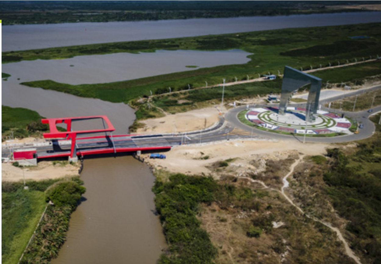
↑ Puente levadizo de la obra Gran Malecón en Barranquilla, Colombia
