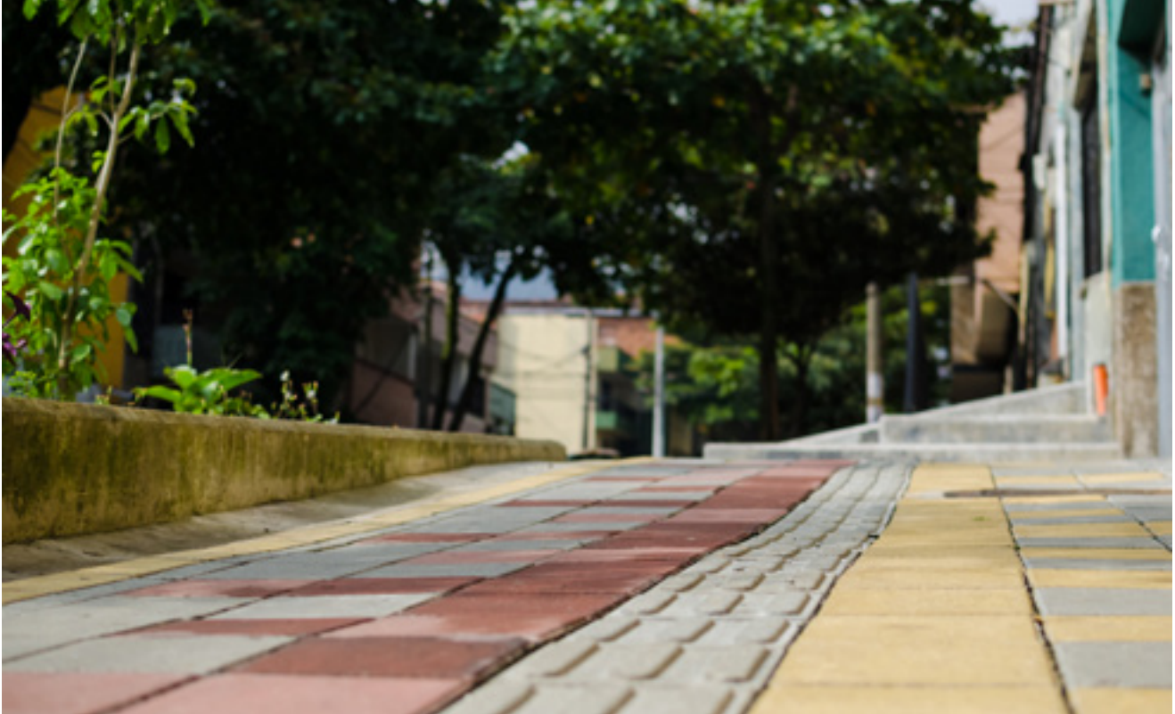
↑ Aplicación del concreto de color en un andén de Medellín, Colombia
