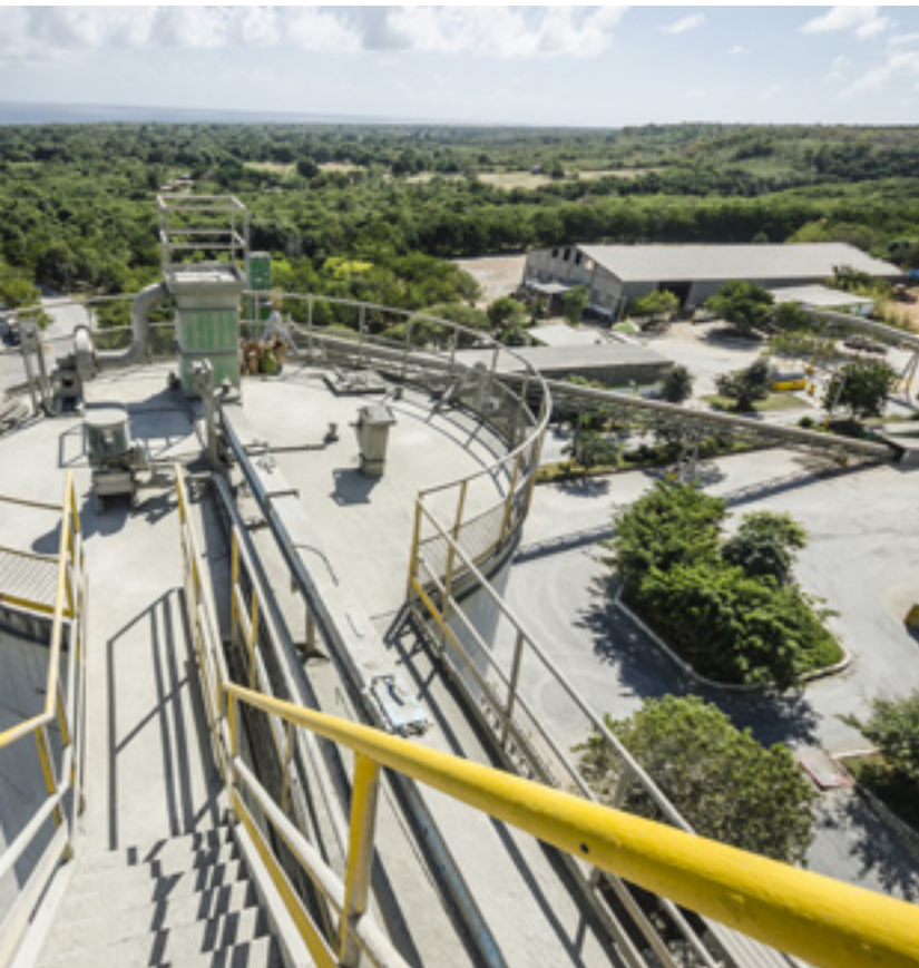
↑ Silo de almacenamiento en República Dominicana
