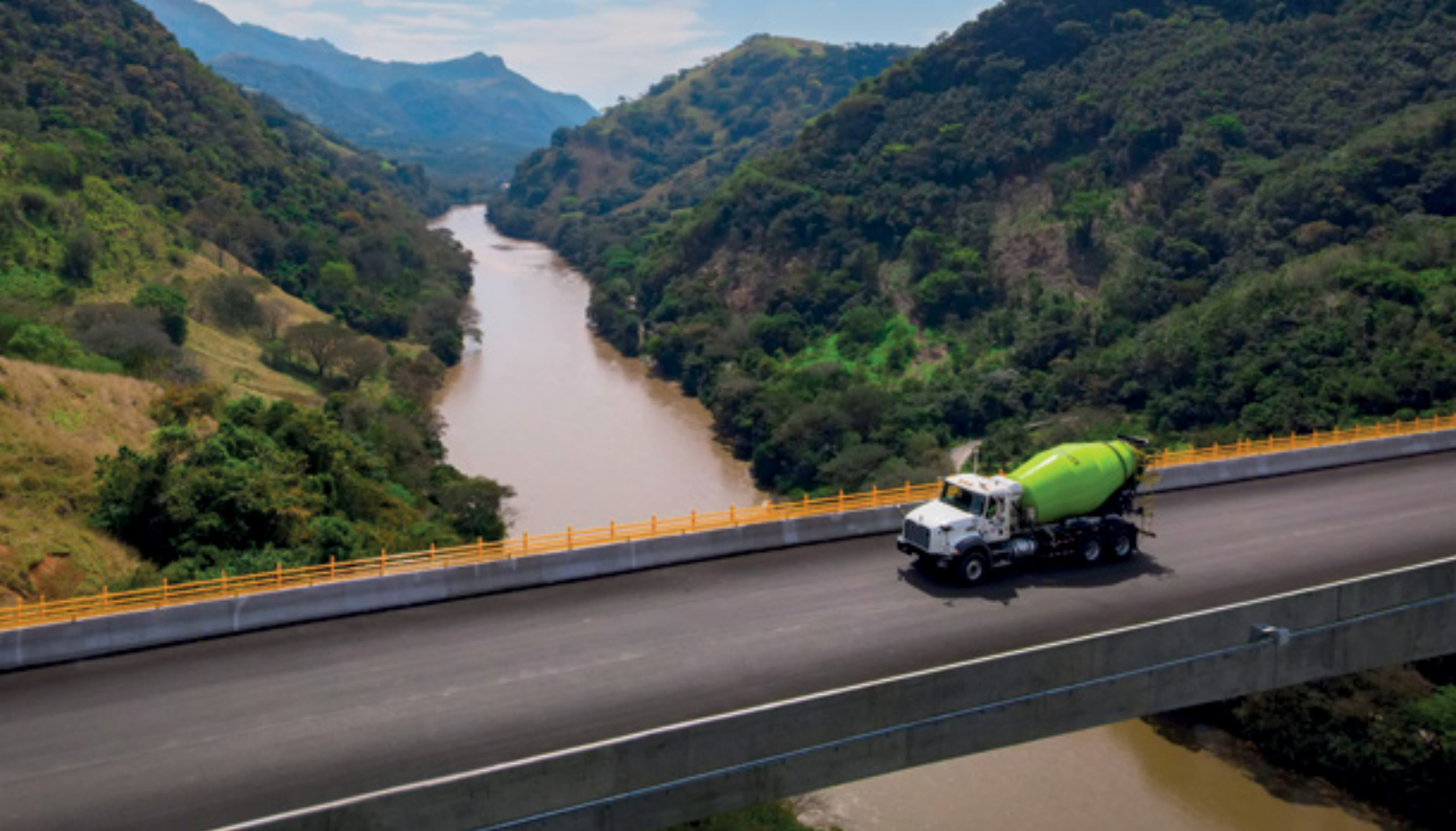
↑ Camión mezclador recorriendo la obra Puente Cauca en Antioquia, Colombia
