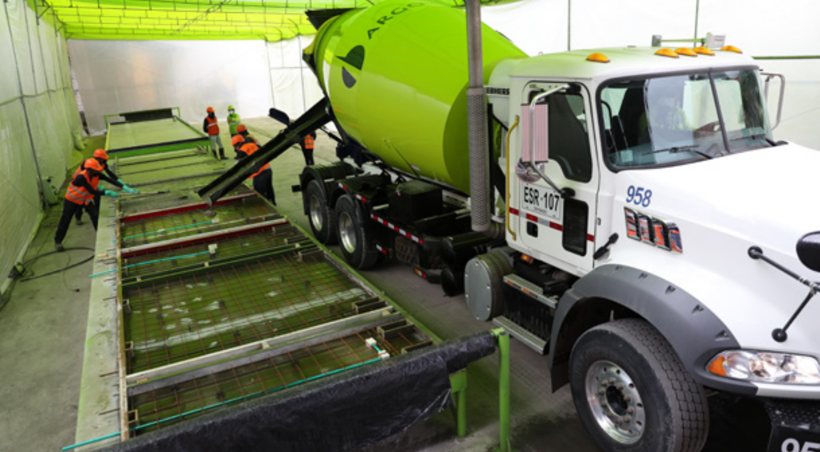
↑ Producción de paneles modulares prefabricados en concreto
