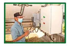
Se desarrolló un proyecto en la comunidad de El Obraje, que consistió en la perforación de un pozo v la instalación de un sistema fotovoltaico de 7.2 Kwp para bombeo del agua a un tanque de almacenamiento. Con ha mejorado proyecto se del agua 200 acceso para familias de la comunidad.
